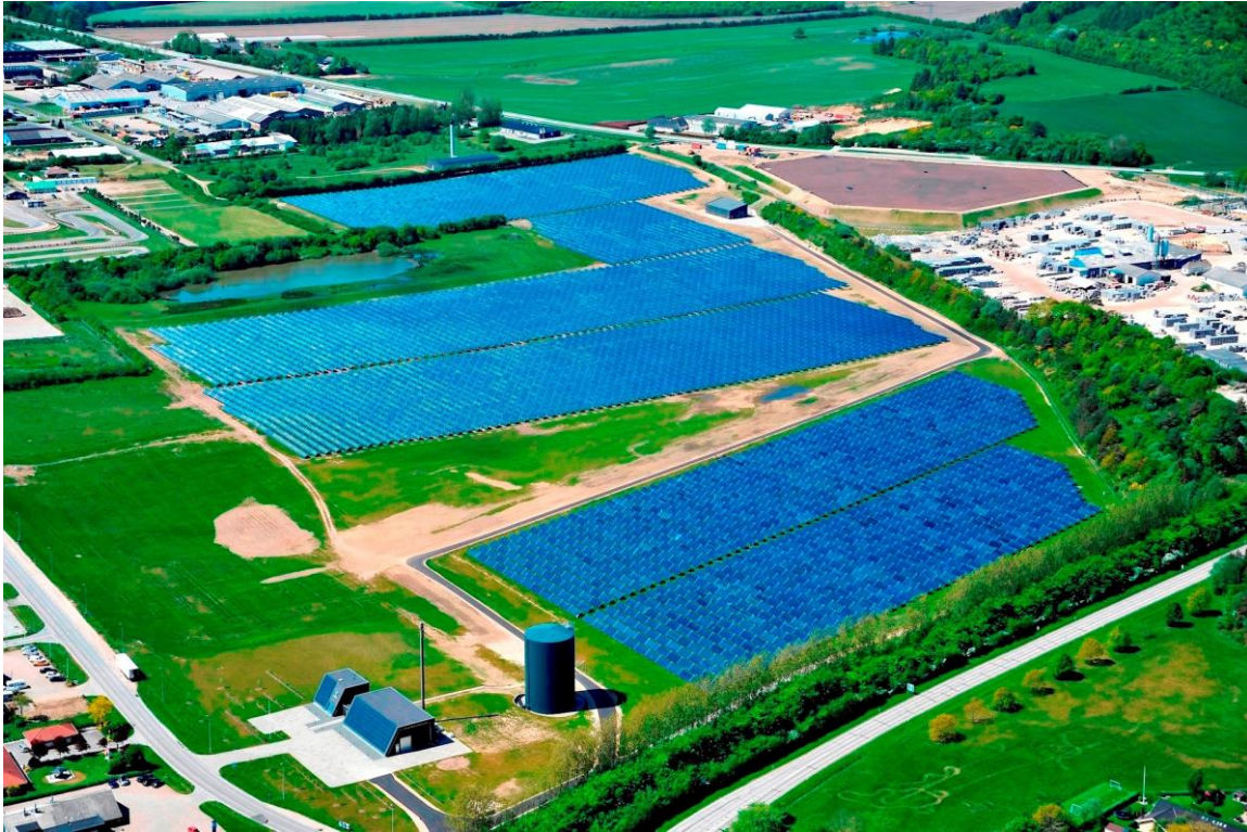
Abb. 23: Solarthermieanlage mit rd. 200.000 m 3 Erdbeckenwärmespeicher (Wärmespeicher oben rechts im Bild/ Bild: www.vojensfjernvarme.dk )
