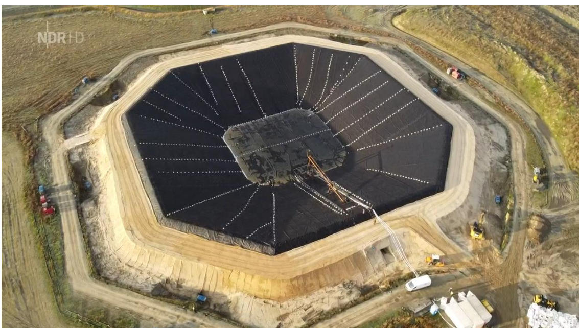
Abb. 24: Bau Erdbeckenwärmespeicher Meldorf mit rd. 43.000 m 3 (Bild: www.ramboll.com )
