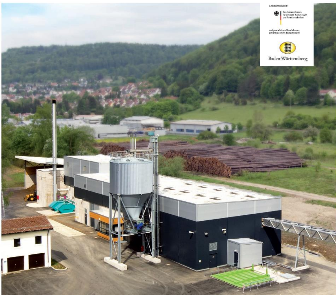
Abb. 26: Biomasse-HKW Kläranlage Ebingen (Bildquelle: Klärschlammverwertung Albstadt GmbH)
